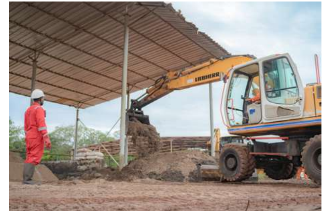
2 Des nutriments sont ajoutés et aérés pour améliorer l'efficacité du processus de traitement.
