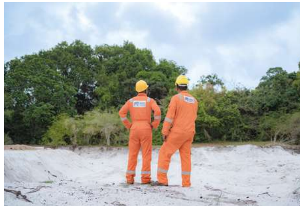
4 Une fois traité à des niveaux conformes aux normes internationales, le sol est utilisé pour remblayer les terrains excavés et recouvert d'une écocouche afin de stimuler la repousse.
